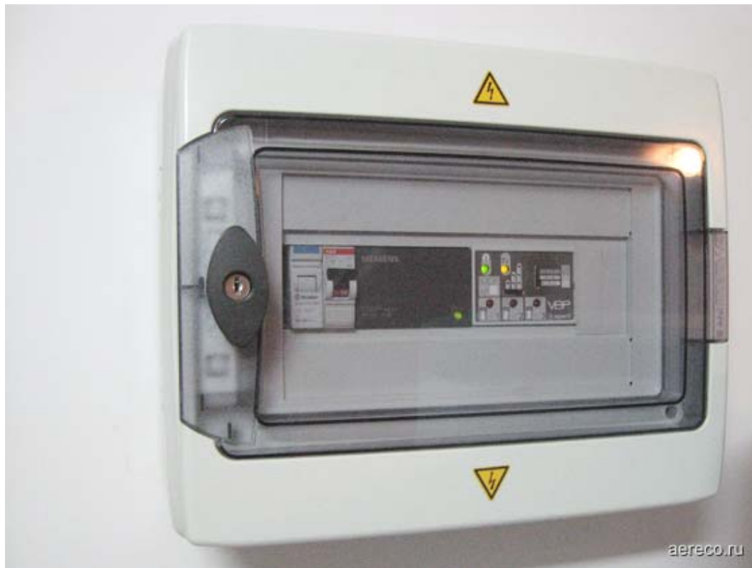
Блок управления. Позволяет одновременно управлять тремя вентиляторами VBP.
