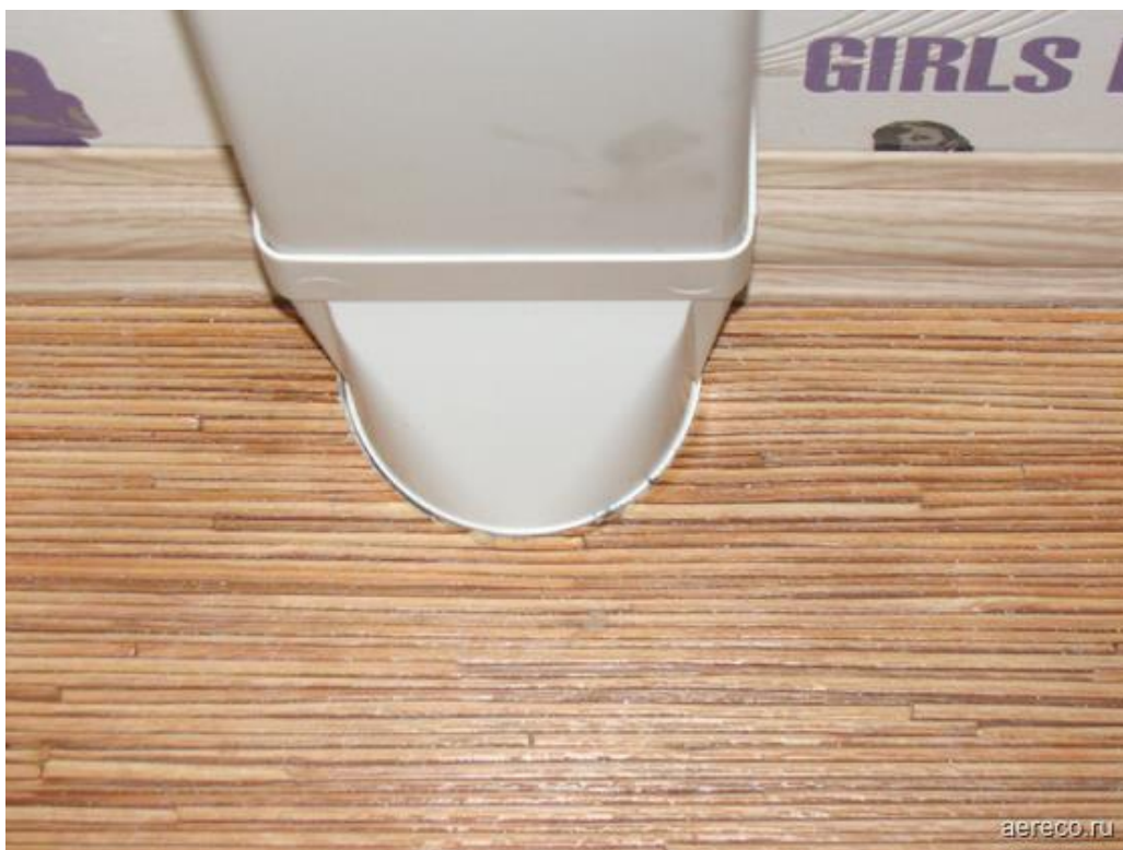
Соединение воздуховода с полом.
