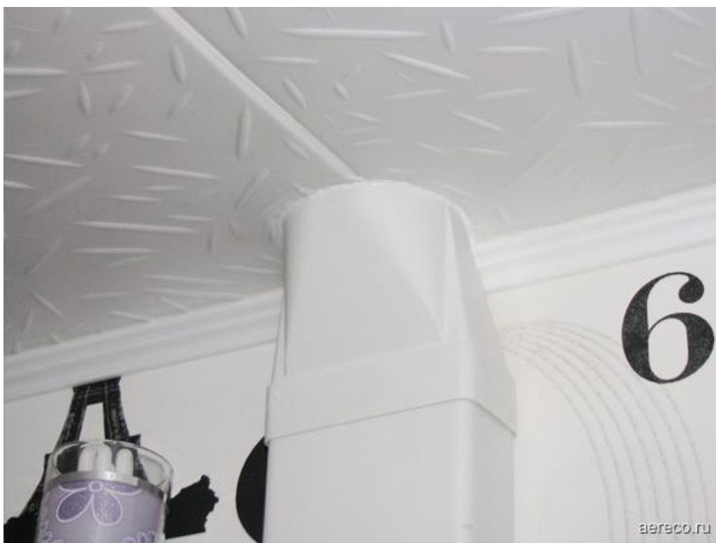
Соединение воздуховода с потолком.
