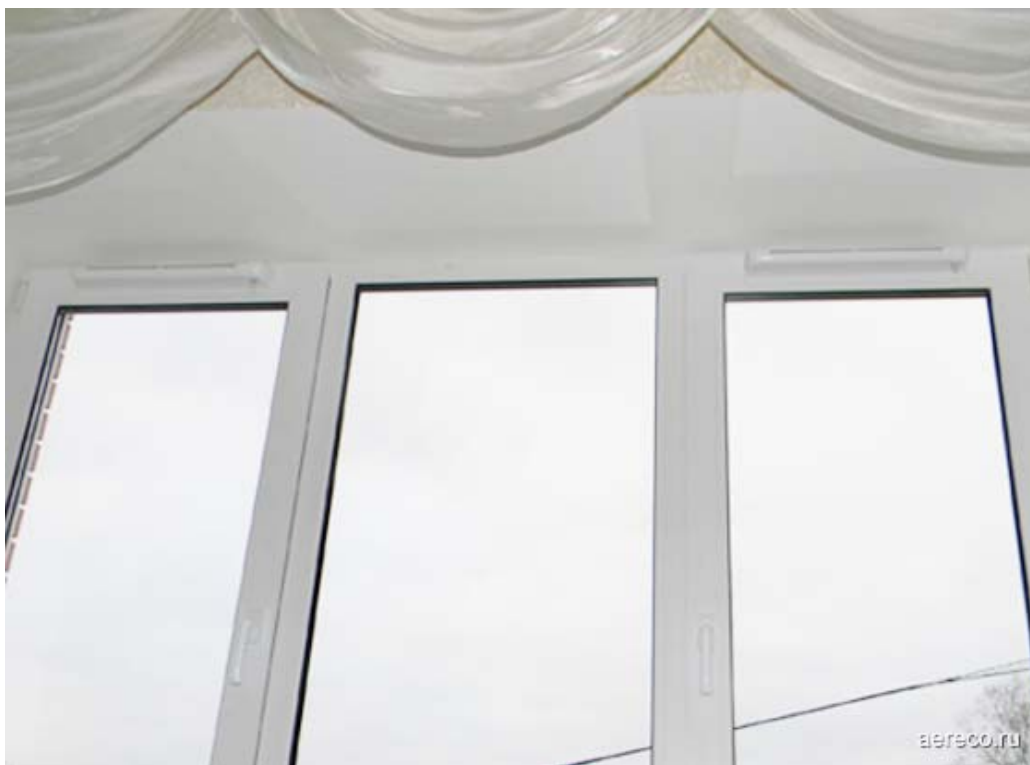
Гигрорегулируемые приточные клапаны ЕНА 2 , установленные на открываемых створках оконного блока.
