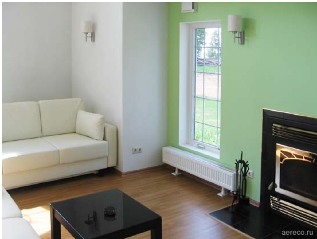
Каминный зал, оборудованный стеновым приточным устройством ЕНТ.
