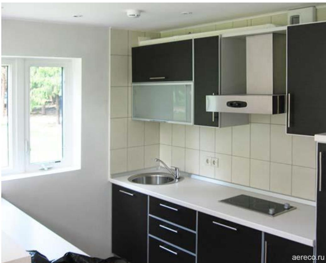
Установленное на кухне гигрорегулируемое [вытяжное устройство ВХС](#) обеспечивает расход воздуха до 150 м<sup>3</sup>/ч.
