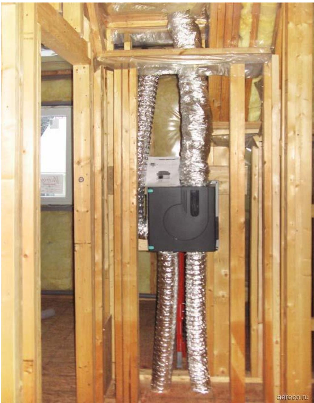
[Вентилятор V4A](#), установленный в техническом помещении. При расходе воздуха 160 м<sup>3</sup>/ч, вентилятор потребляет всего 22 Вт.
