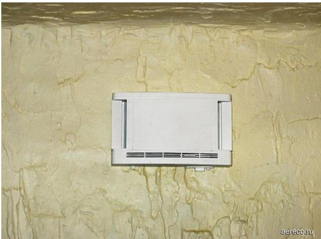
Установленный на стене [приточный клапан ЕНТ](#) обеспечивает расход воздуха от 5 до 40 м<sup>3</sup>/ч при 10 Па и, в комплекте с аксессуарами, уменьшает уличный шум на 52 дБ.
