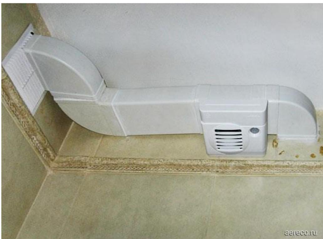
[Вытяжное устройство с датчиком присутствия](#) позволяет автоматически включать пиковый режим расхода воздуха при нахождении человека в помещении.
