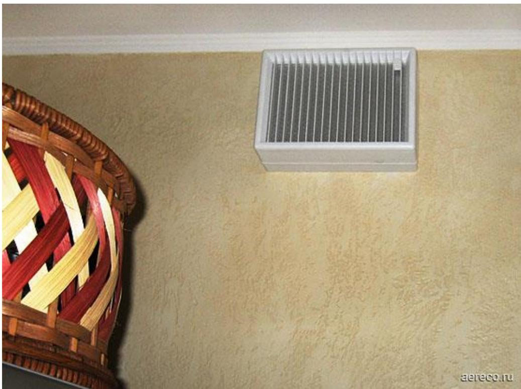
Установленный на кухне алюминиевый фильтр FBE 1089 позволяет предотвратить попадание жировых соединений в систему воздуховодов.
