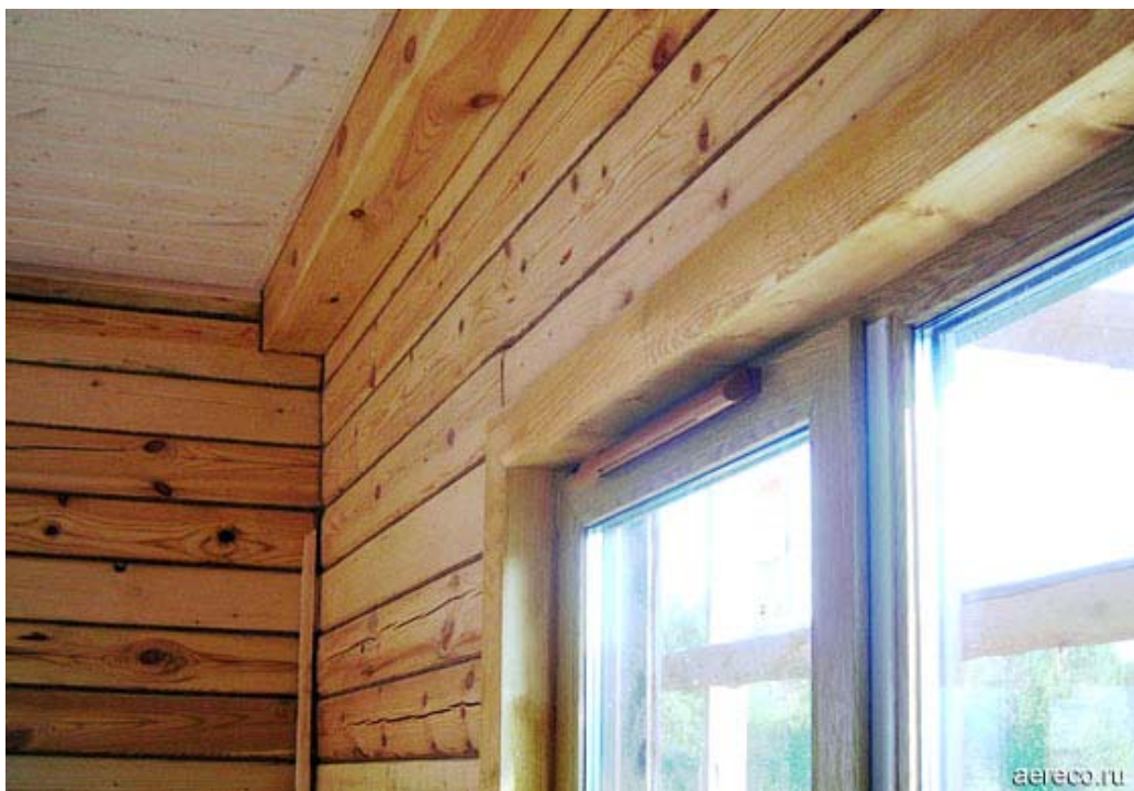
Приточный клапан EMM, установленный в верхней части деревянного окна.
