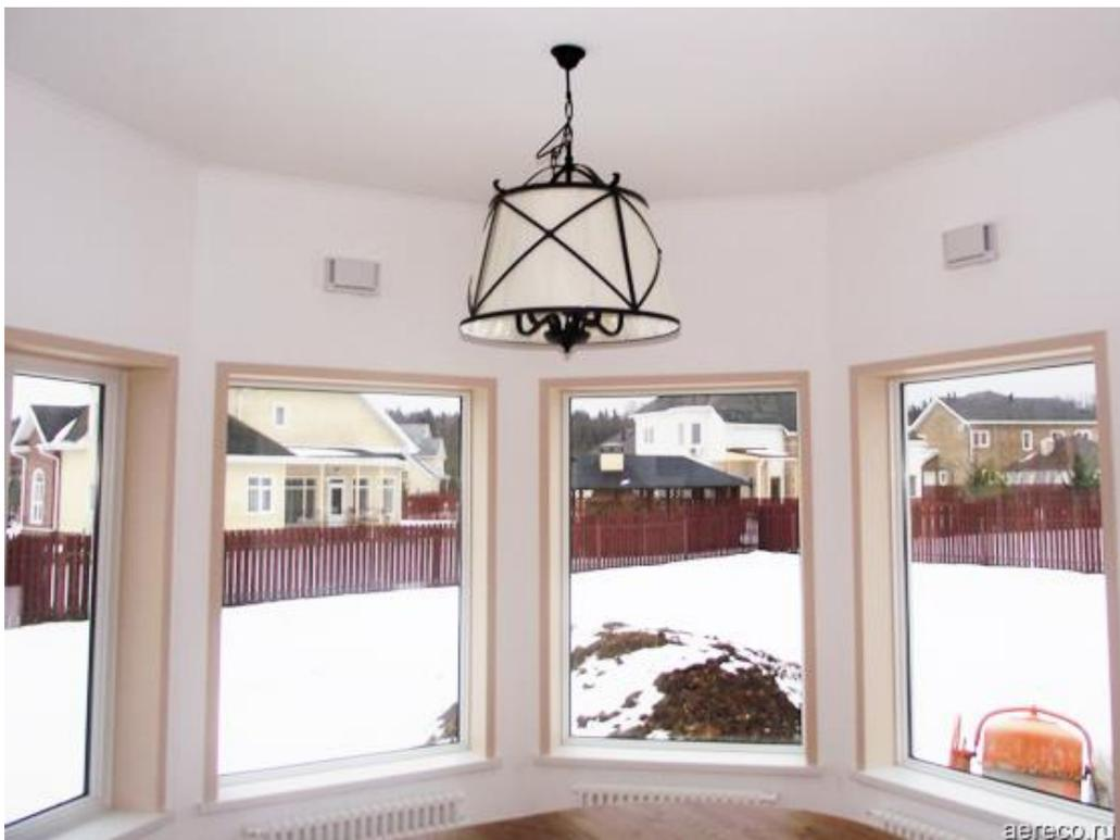
[Стеновые приточные устройства ЕНТ](#), установленные в эркерной части гостиной на первом этаже дома.
