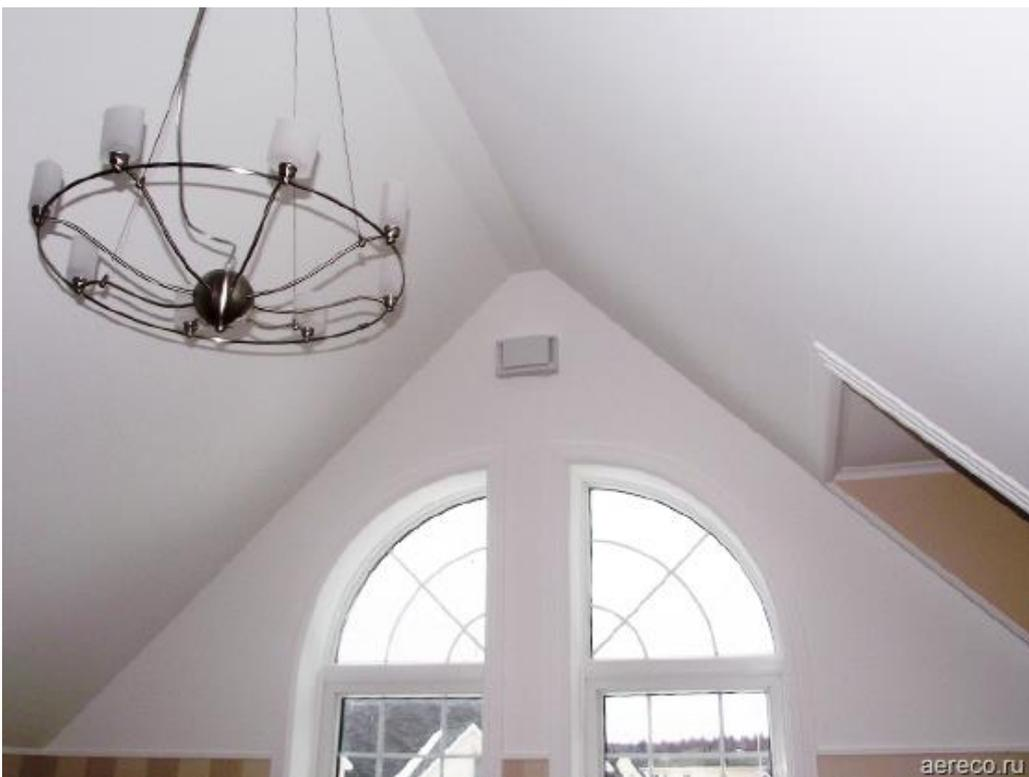
Стеновой клапан обеспечивает приток воздуха от 5 до 40 м<sup>3</sup>/ч при 10 Па.
