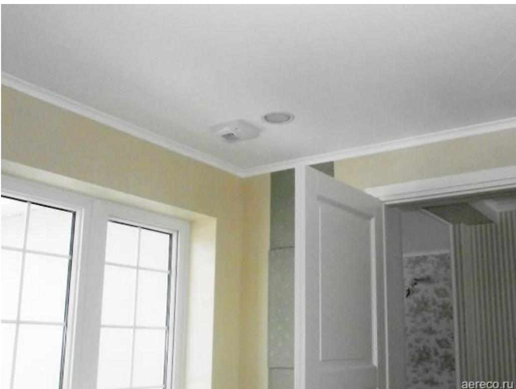
[Вытяжное устройство ВХС](#), установленное в санузле. Датчик присутствия активирует пиковый режим расхода воздуха, увеличивая воздухообмен до 130 м<sup>3</sup>/ч при 100 Па.
