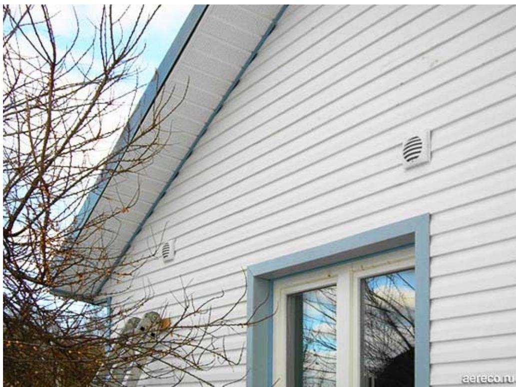
Установленные на фасаде коттеджа два настенных козырька А-ЕНТ закрывают отверстия для стеновых приточных клапанов ЕНТ.
