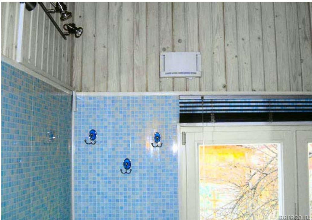
Стеновой приточный клапан ЕНТ обеспечивает расход воздуха от 5 до 40 м<sup>3</sup>/час при 10 Па.
