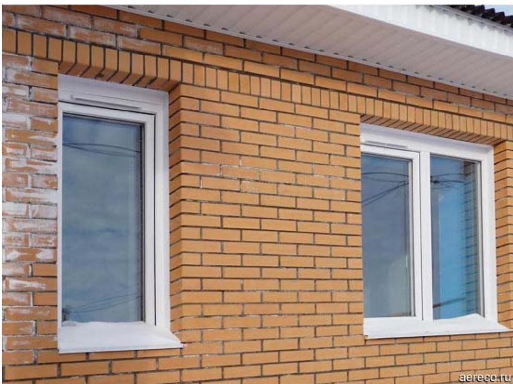
Внешний вид окон с установленными приточными клапанами EMM. Наружные козырьки защищают помещение от проникновения воды.
