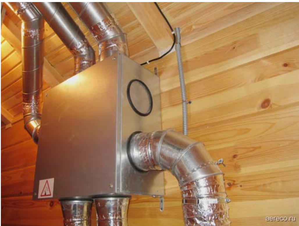
Вентилятор VAM со спирально-навивными оцинкованными воздуховодами.
