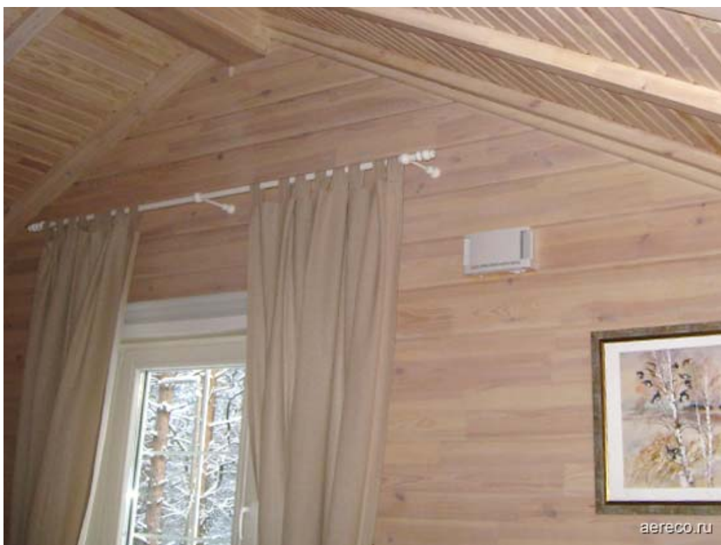
Стеновое приточное устройство ЕНТ обеспечивает приток до 40 м 3 /ч при перепаде давления 10 Па.
