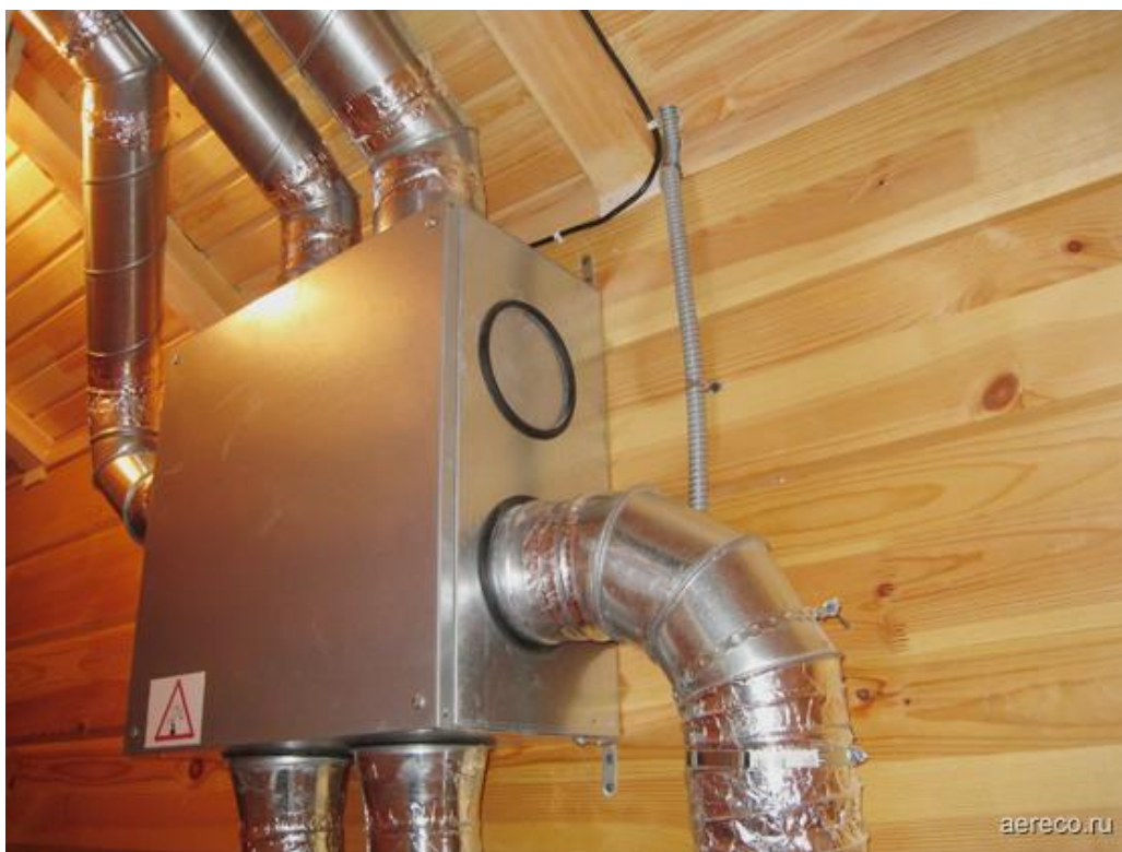
Вентилятор VAM со спирально-навивными оцинкованными воздуховодами.
