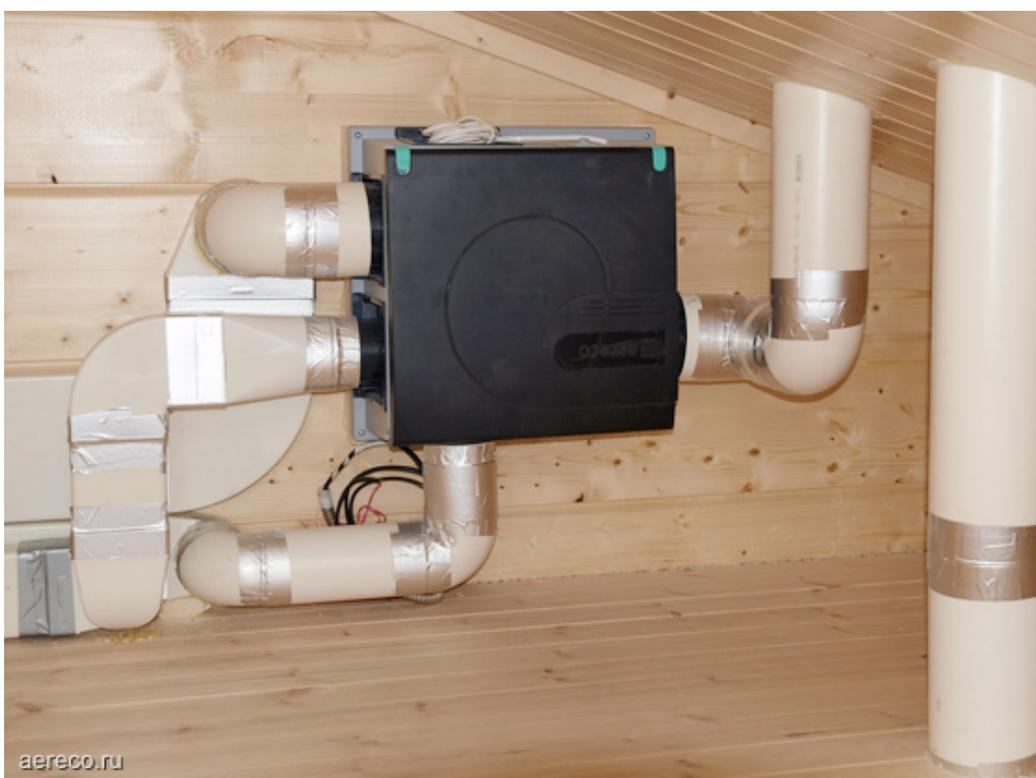
Вентилятор V4A может обслуживать до 4 вытяжных устройств. Благодаря двигателю с электронным управлением достигается низкое потребление энергии (менее 13 Вт при расходе воздуха 40 м<sup>3</sup>/ч).
