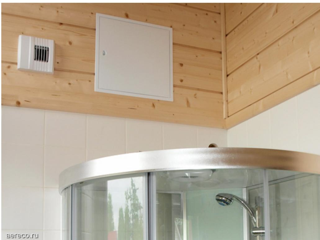
Душевая комната с установленным вытяжным устройством ВХС. Наличие ревизионного люка позволяет скрыть внутренние коммуникации и обеспечить доступ к вентилятору для технического обслуживания.
