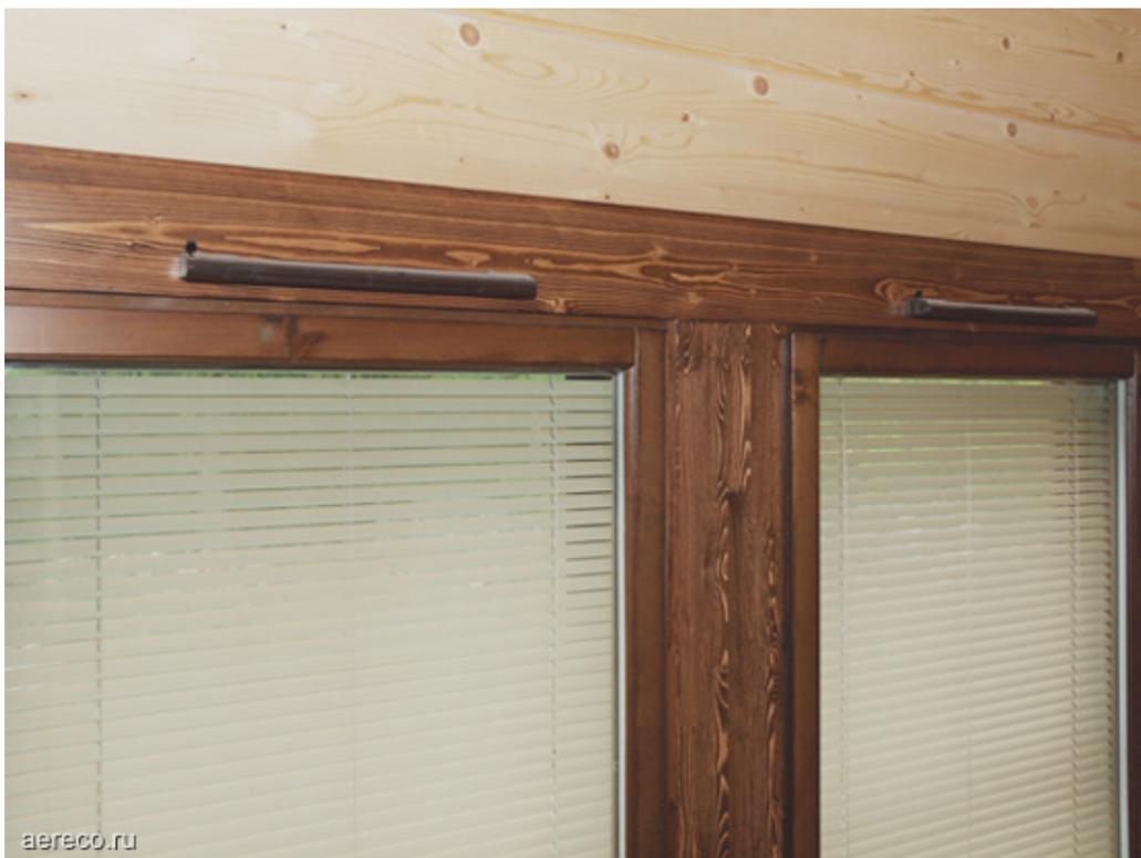
Приточные устройства ЕММ (цвет – тик), установленные в современные деревянные окна.
