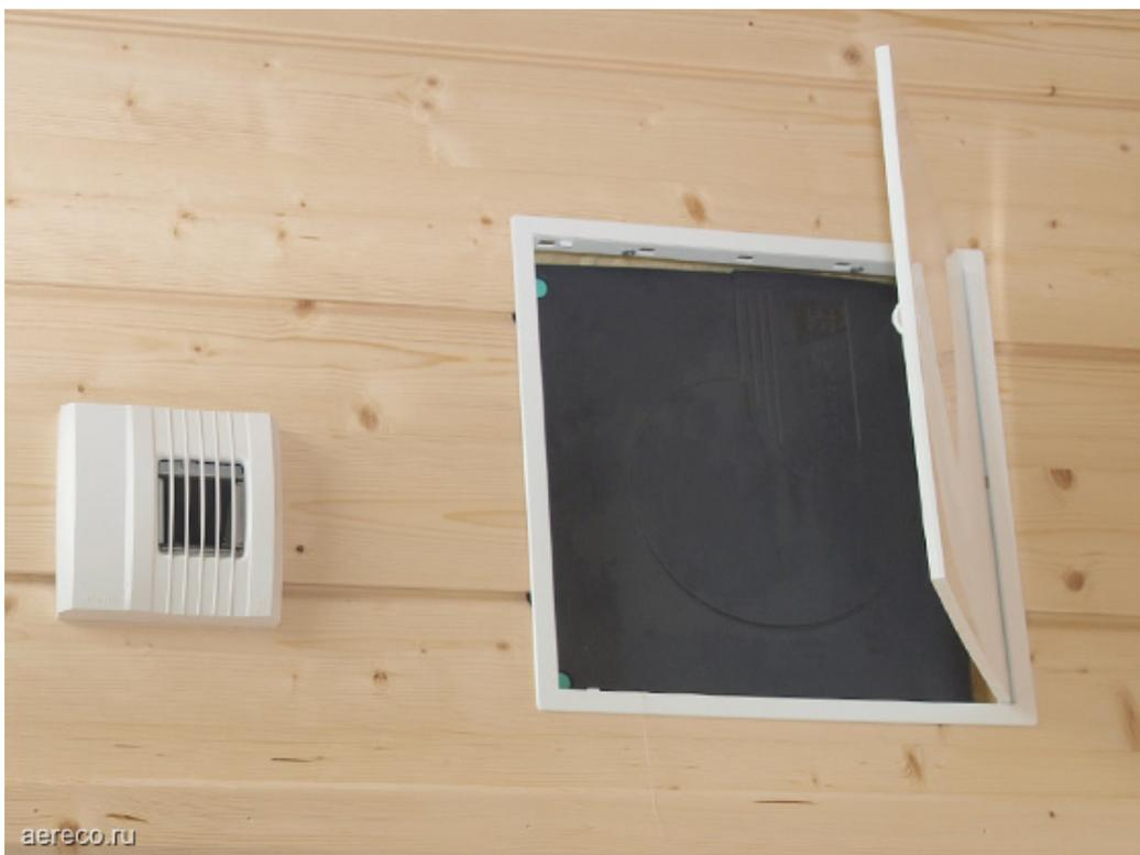
Благодаря компактности и низкому уровню собственно шума, вентилятор V4A можно устанавливать внутри жилой зоны.
