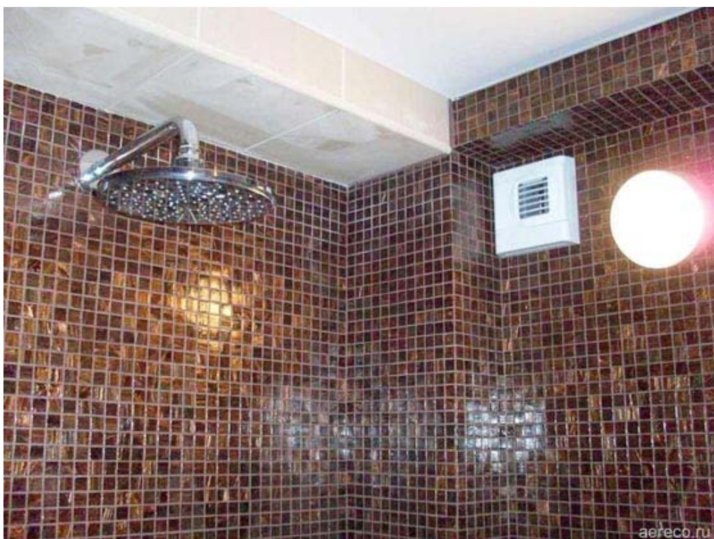
Установленное в душе вытяжное устройство VXS.
