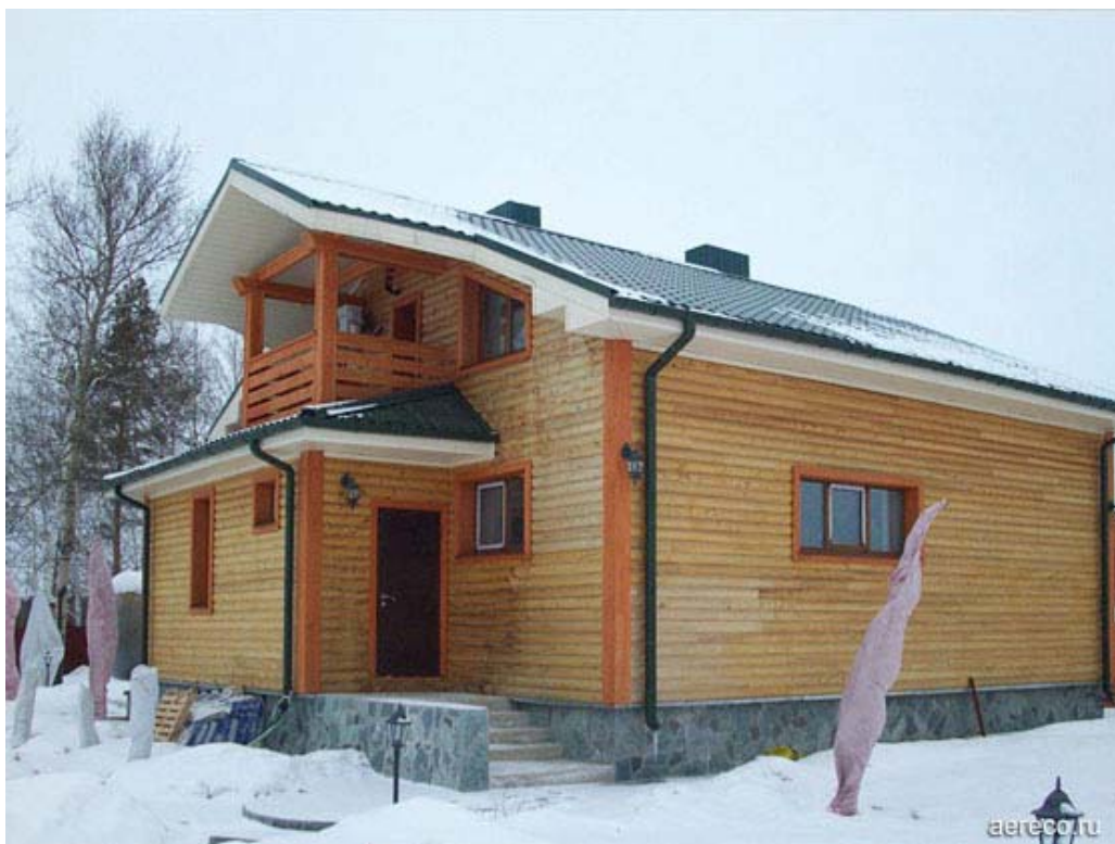
Внешний вид коттеджа с установленной системой вентиляции Aereco.
