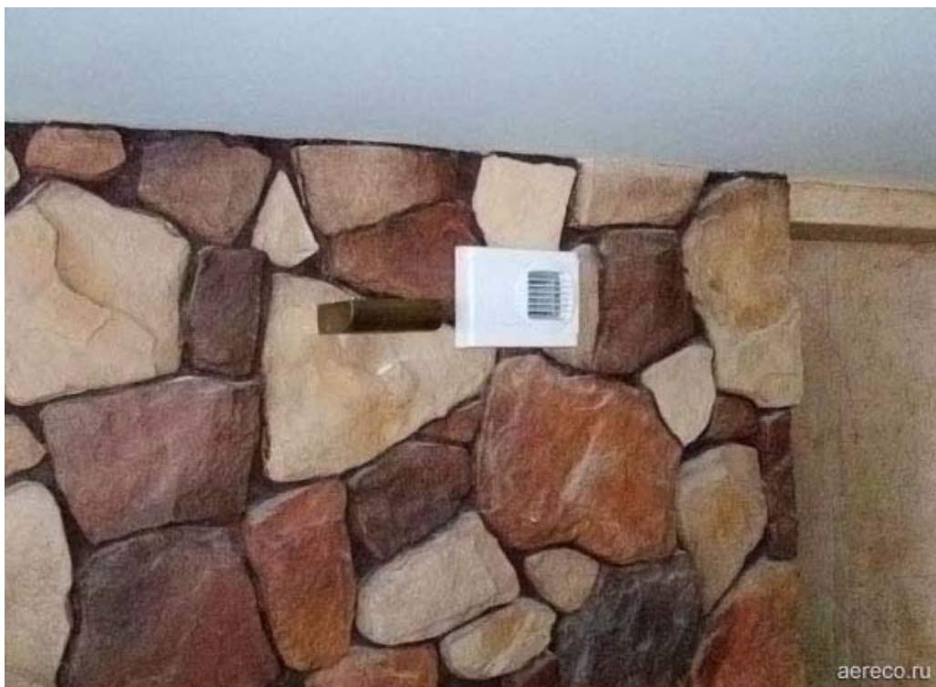
Вытяжное устройство VXL 889 обеспечивает расход воздуха от 12 до 70 м 3 /час при 100 Па.
